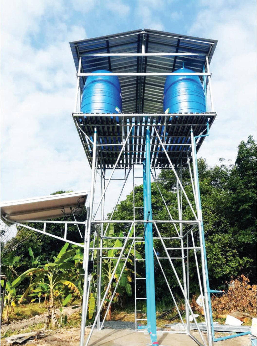
การติดตั้งแผงโซลาร์เซลล์กับโครงสร้างถังเก็บน้ำ
