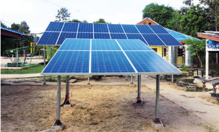
ภาพตัวอย่างการติดตั้งกับโครงเหล็กแบบยึดติดกับพื้น
