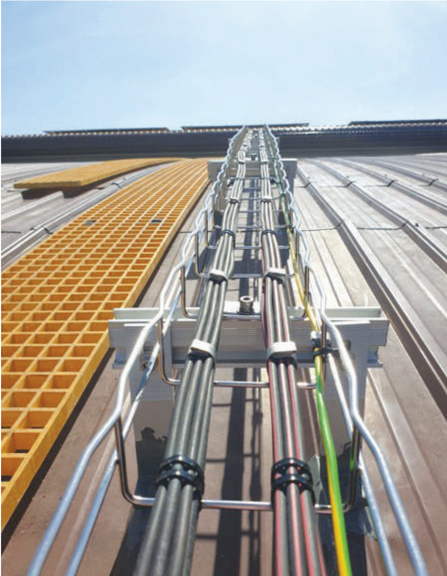
Basket Tray สแตนเลสเกรด 304 เดินสายไฟ
