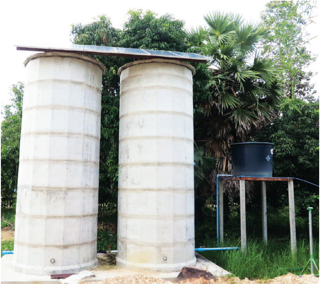
การติดตั้งแผงโซลาร์เซลล์กับถังเก็บน้ำ
