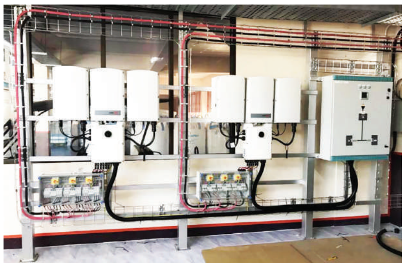
การเดินสายไฟ ใน BASKET TRAY และวางอินเวอร์เตอร์
